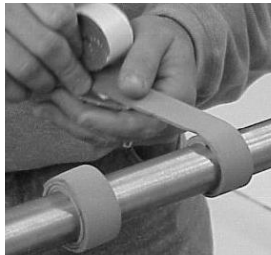
شکل (۱۲): نصب آب‌بندها در محل اتصال لوله با محفظه.
